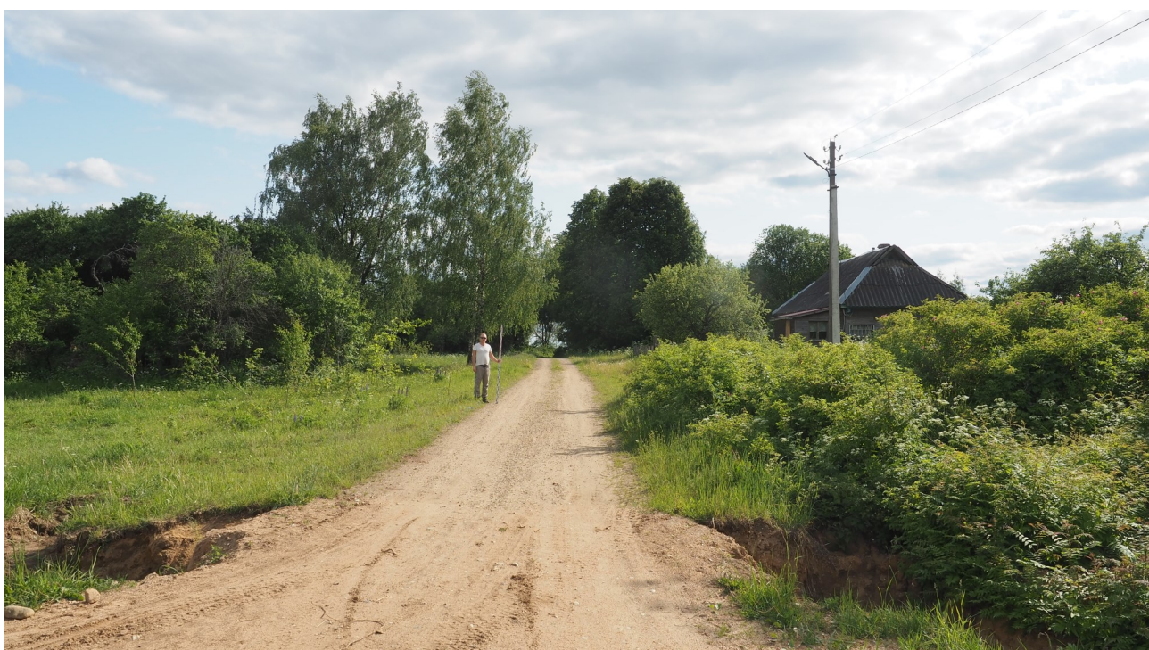
Рис. 10. Калужская область, Спас-Деменский район. 2023 г. Археологическое обследование по объекту: «Уличные газопроводы дер. Теплово». Точка фотофиксации № 1. Вид с юго-запада.
