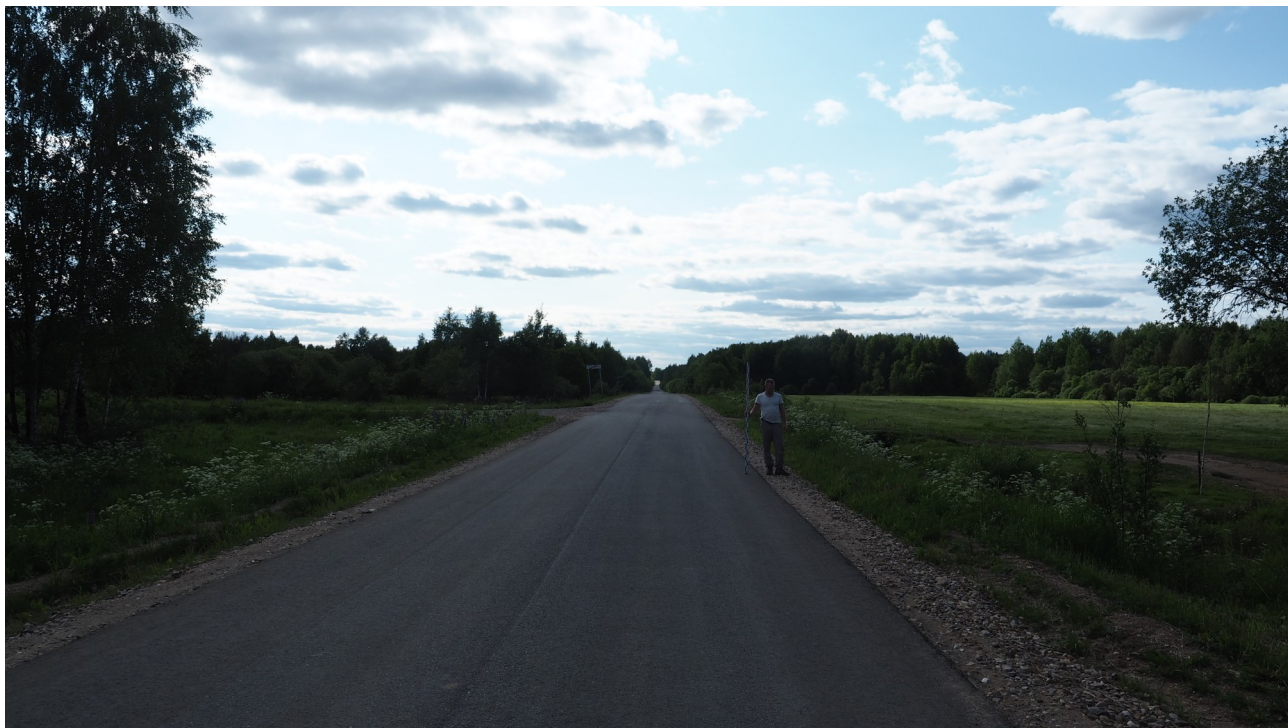
Рис. 23. Калужская область, Спас-Деменский район. 2023 г. Археологическое обследование по объекту: «Уличные газопроводы дер. Теплово». Точка фотофиксации № 7. Вид с юго-востока.
