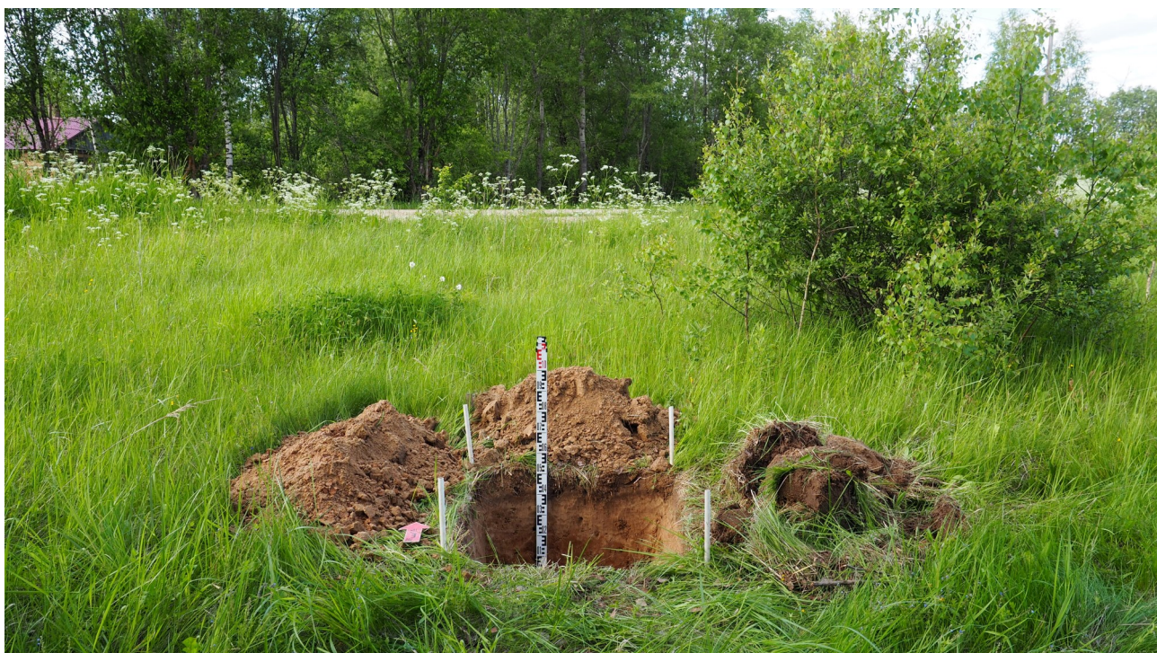
Рис. 31. Калужская область, Спас-Деменский район. 2023 г. Археологическое обследование по объекту: «Уличные газопроводы дер. Теплово». Вид на раскопанный шурф 2 с юга.
